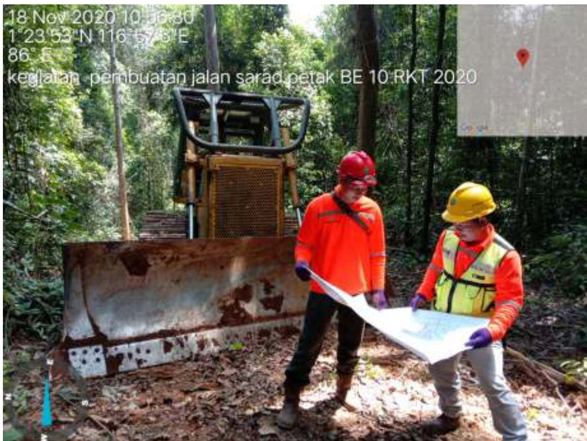
Gambar. 2 .Sebelum melakukan pembukaan jalan sarad perlu melakukan kordinasi kembali dengan Operator Buldoser, untuk menentukan jalan sarad yang akan dibuka sesuai dengan trace jalan yang telah dibuat pada peta rencana
