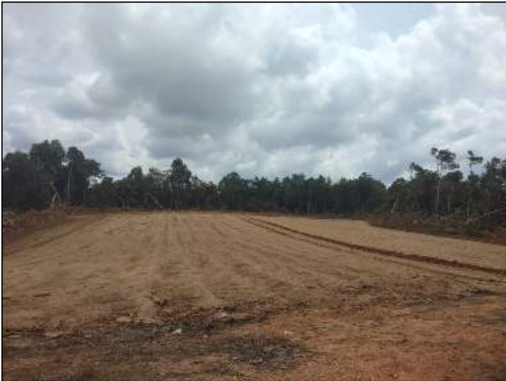
Dokumentasi Bantuan Alat Berat untuk Pembukaan Lahan TPSA Desa Miau Baru
