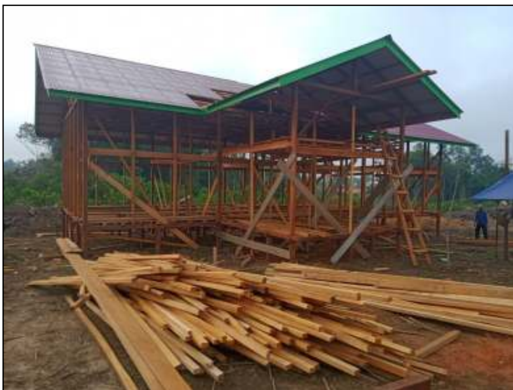
Bantuan Material Kayu untuk pembangunan kantor Desa Miau Baru Utara
