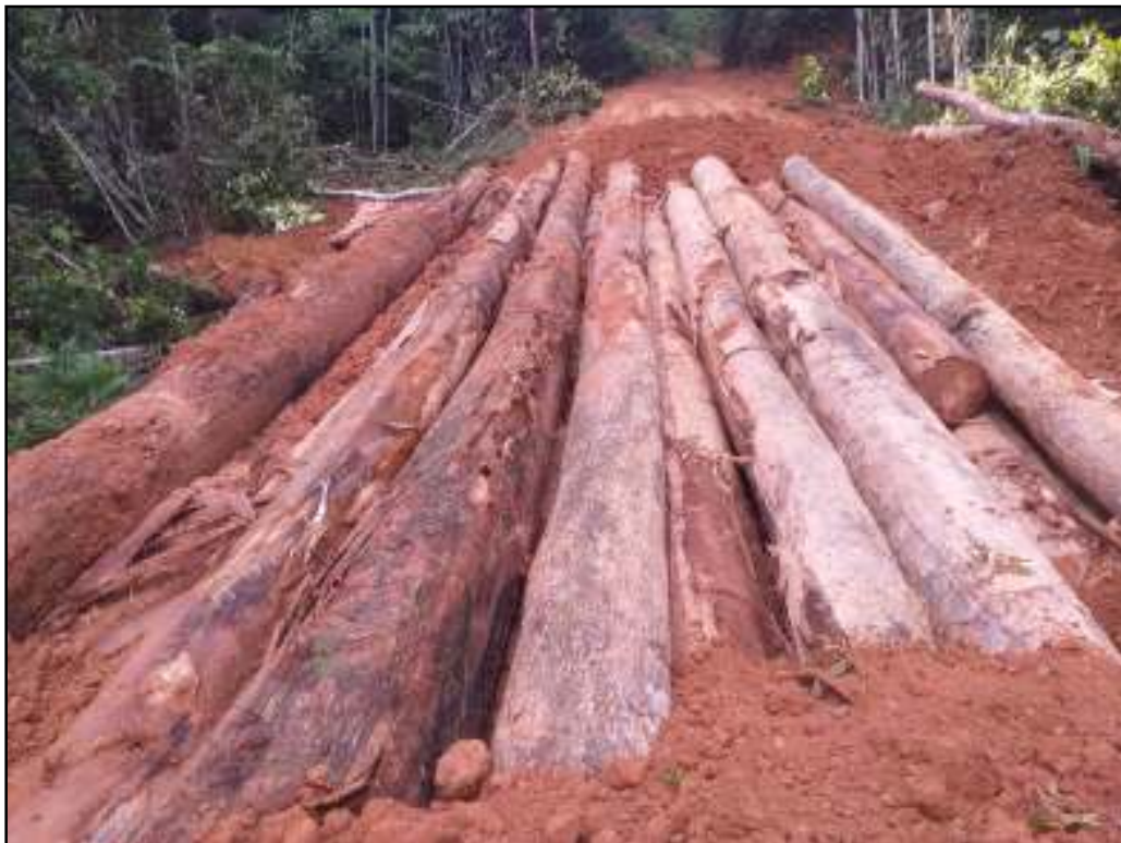
Dokumentasi Kegiatan Perbaikan Akses Jalan dan Jembatan Hutan Lindung Wehea
