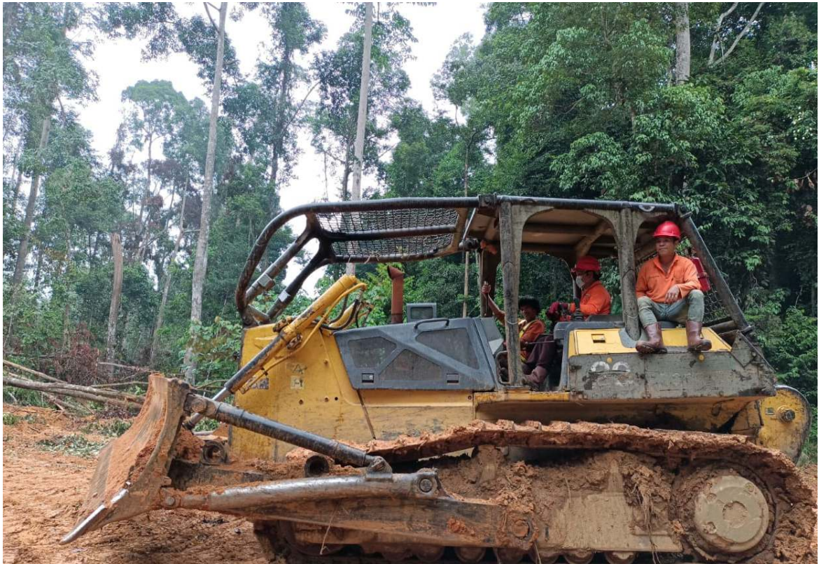
Gambar : 3. Pembuatan jalan sarad
