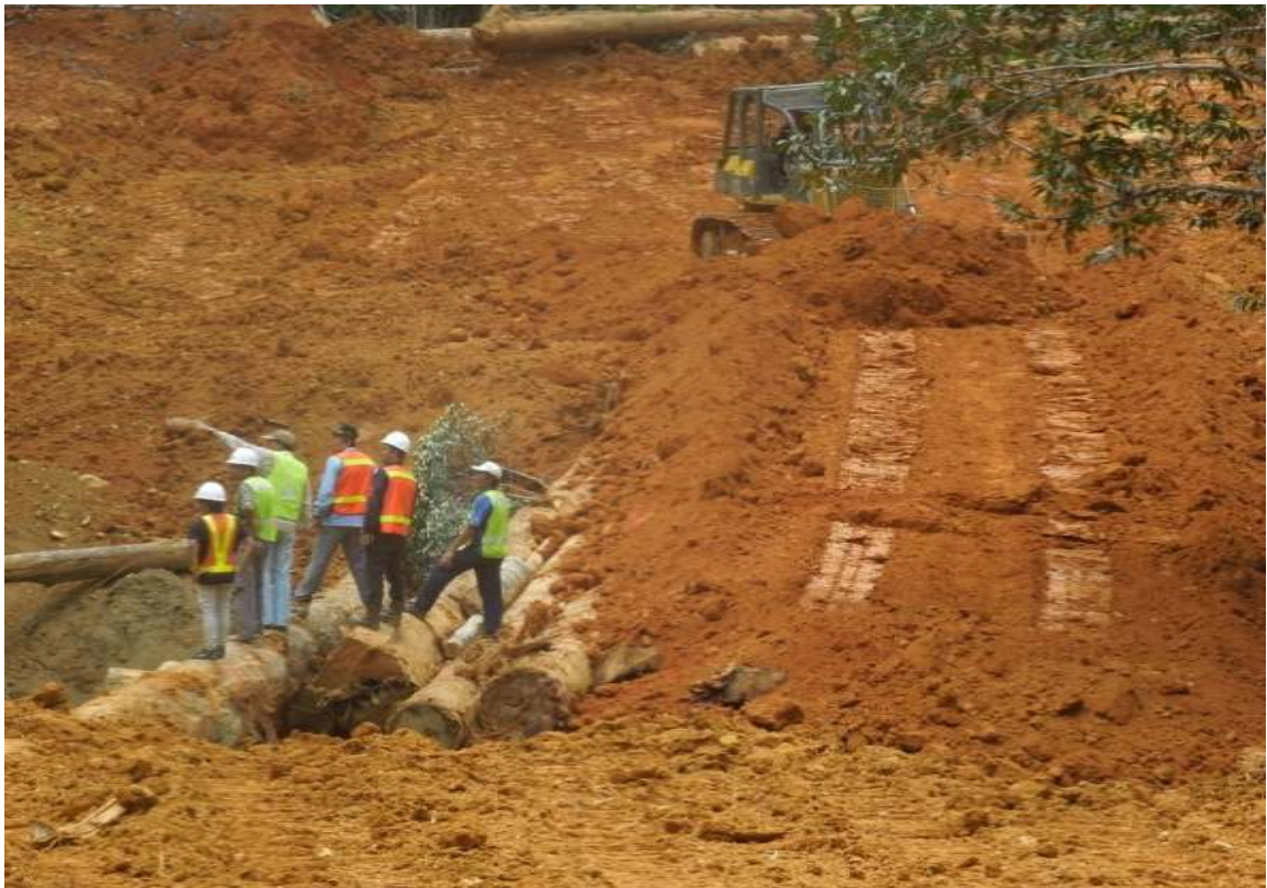
Gambar : 1. Proses pembuatan jalan dan jembatan
